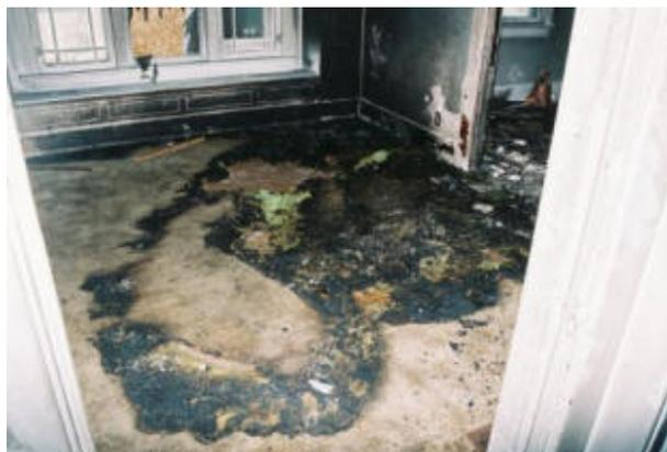
**Fotografia 4 – Marca de combustão por acelerante no piso, 2007**
